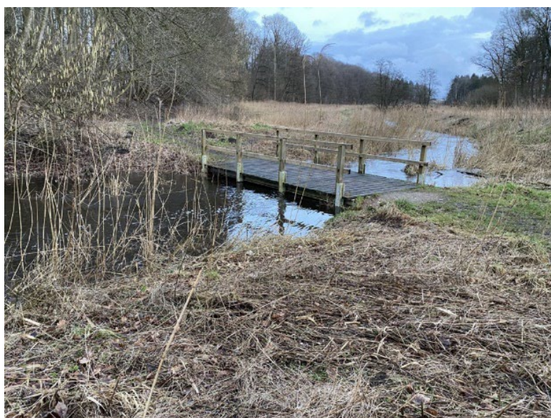
Foto: IBS Ingenieurbüro Schydlo – 10.02.2022
